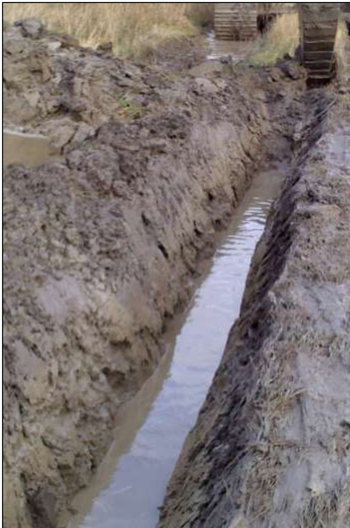
Figur 4. Schakten blev omedelbart vattenfyllda och troligen har det funnits en tidigare okänd vattenkälla i närheten. Foto: Susanna Eklund
