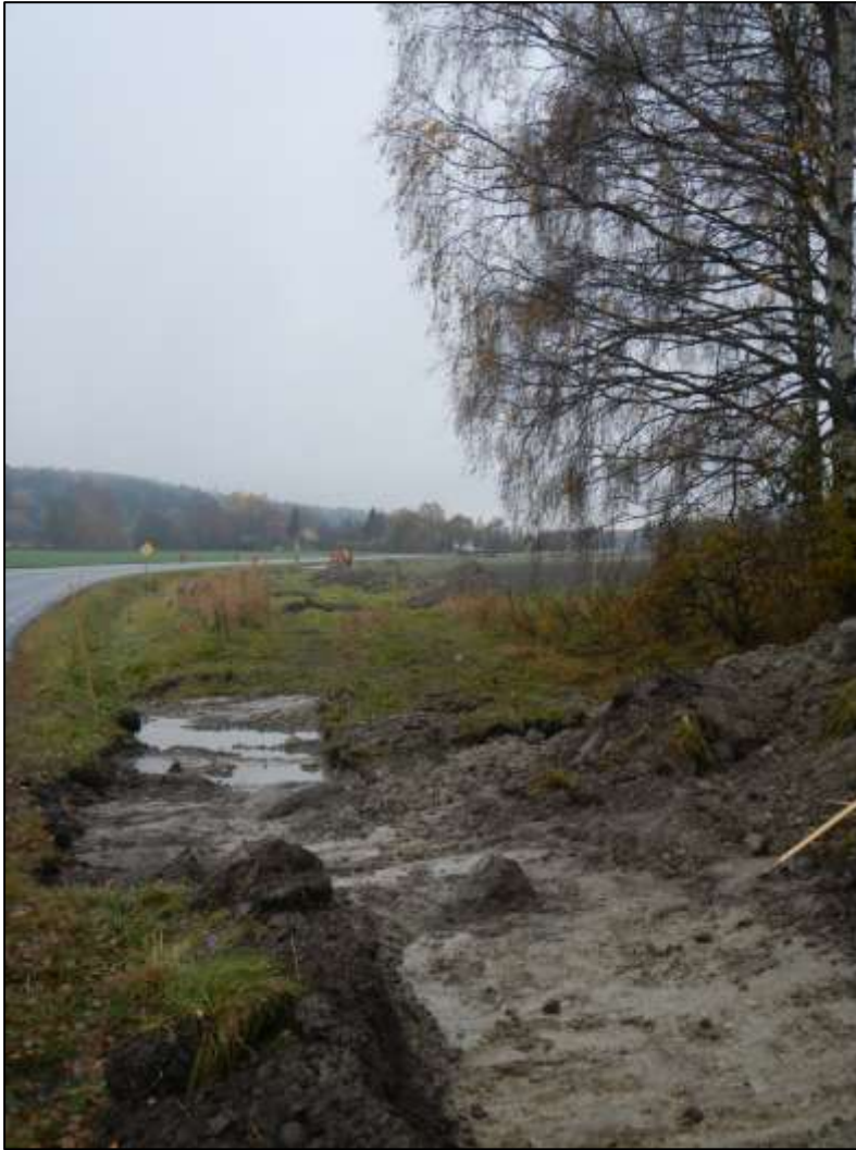
Figur 10. Schakt 225 drogs i övergången mellan ängsmark och impediment. Foto från öster av Anneli Sundkvist, SAU.
